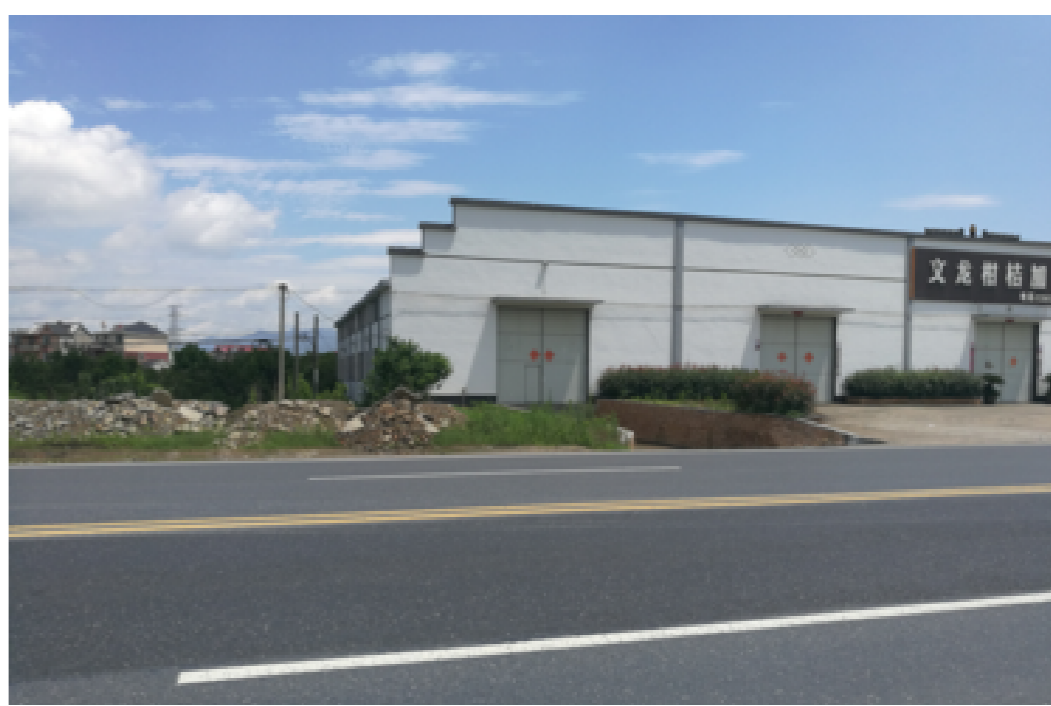
320国道航埠段乱堆乱放
